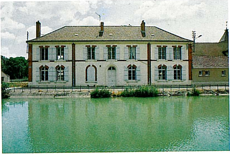
Fig. 17 - Edifício municipal inteiramente de terra crua, construído no final do séc. XIX em Biseul, sul da França.
