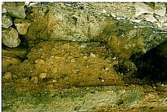
Fig. 31 - Taipa de Salir. Base duma torre, assente sobre afloramento de calcário.
