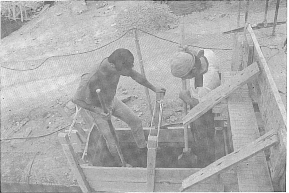
Fig. 38 - Construção em taipa: uma tradição renovada em Mértola.
