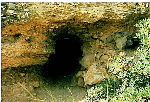
Fig. 32 - Taipa de Paderne. À esquerda, notam-se os estratos que compõem a assentada.
