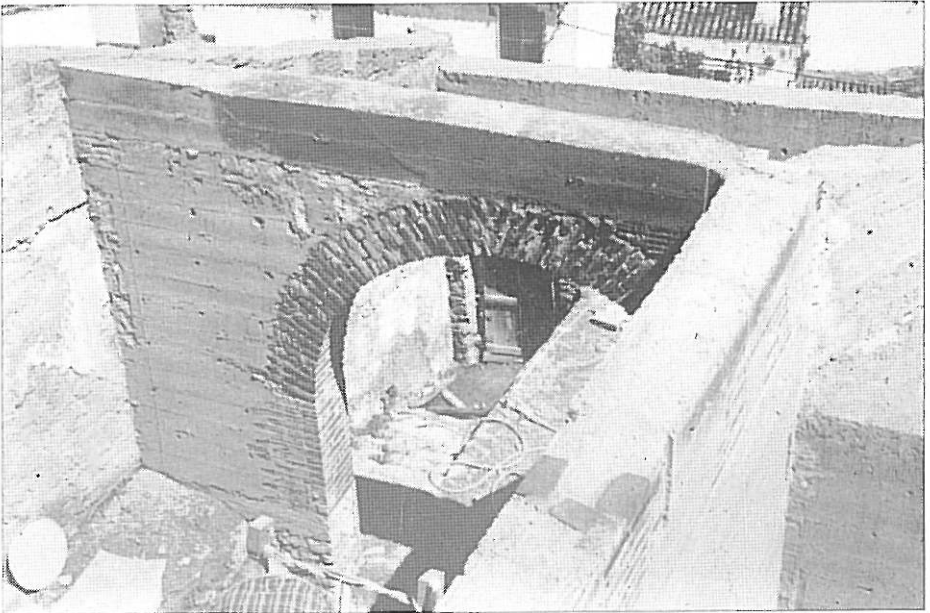
Fig. 39 - Mértola. Edifício experimental em construção.
