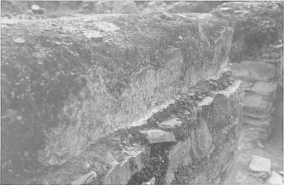
Fig. 36 - Mértola. Parede em taipa acima de 70 cm do solo.
