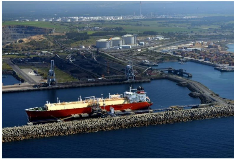
Imagem 10. Gás natural - Fonte: Sítio da REN – Gasodutos
