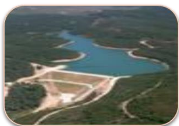
Aproveitamento Hidroagrícola da Várzea de Calde, concelho de Viseu
