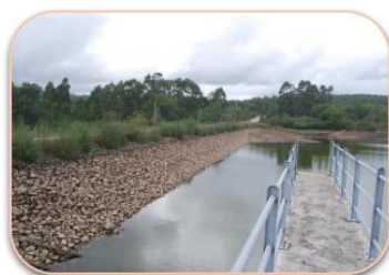
Aproveitamento Hidroagrícola de Pereiras, Pinheiro de Lafões, concelho de Oliveira de Frades
