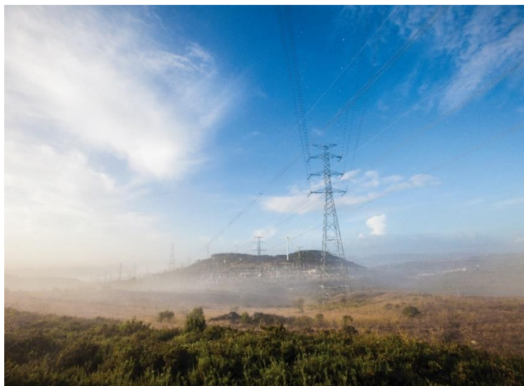
Imagem 13. Linhas de muito alta tensão | Servidão administrativa da REN. Fonte: Sítio da REN
