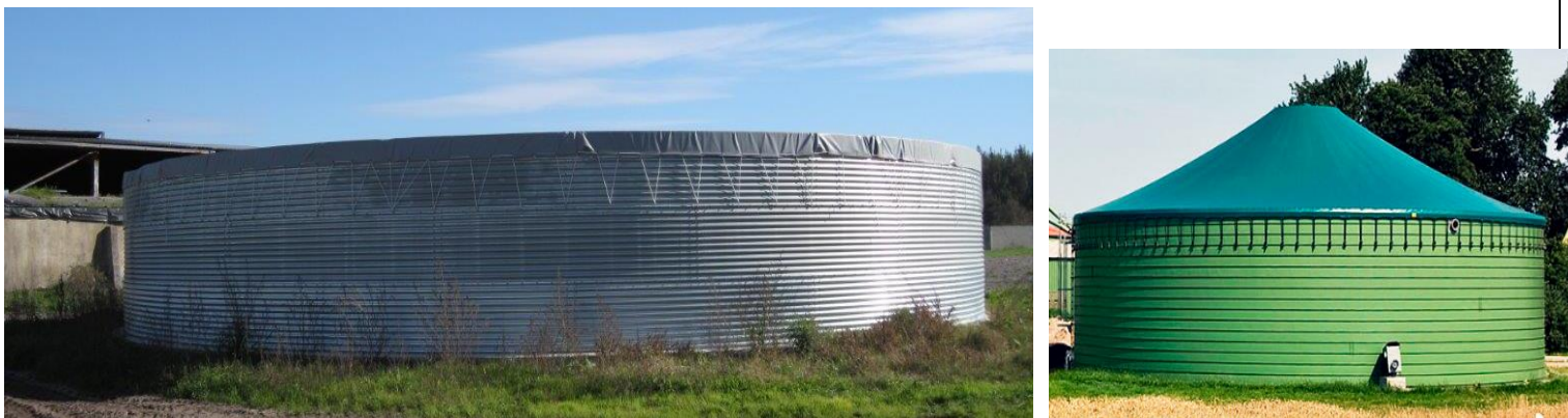
Reservatórios de Chorume cobertos
