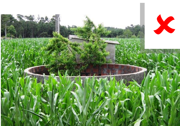
Fig. 13 – Incumprimento da distância de proteção à captação água subterrânea.
